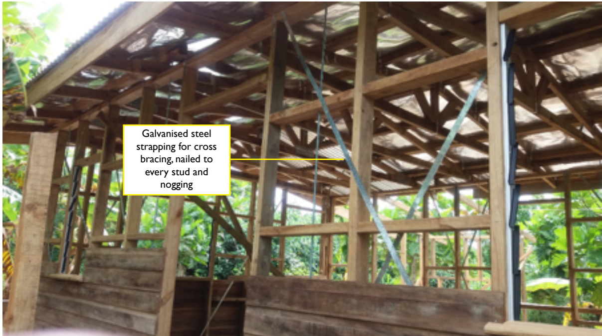
Droini A16: Tutu ni duru ni lalaga kei nai vesu sitila me kena I Sa (Vakarautaka na: Fiji Rural Housing Unit)
